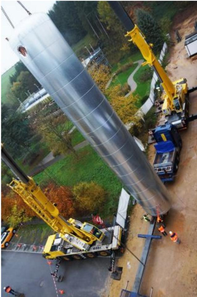
Initiée par l'administration des bâtiments publics, la construction du Lycée technique pour Professions de Santé d'Ettelbrück, projet pilote répondant au concept d'énergie positive et écologique, se poursuit. L'installation du réservoir saisonnier prévu pour le projet, le plus grand du type installé dans un bâtiment fonctionnel au Luxembourg, s'est déroulée mercredi 8 novembre 2017.
